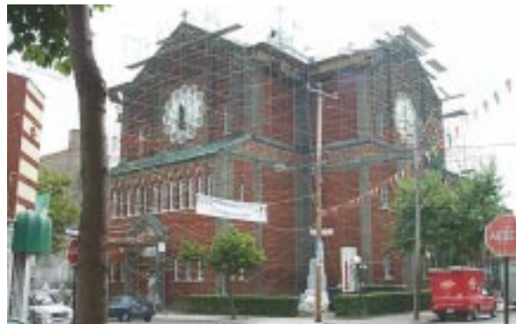
L'extérieur de l'église lors d'une phase de restauration de la maçonnerie en 2000. Source : CIRQ
