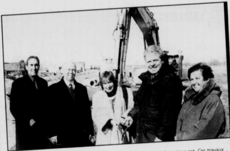
La Ville de Lachenaie lance des travaux de 10 000 000 $ dans le secteur est. Ces travaux d'infrastructures permettront d'accueillir le nouvel hôpital dans les meilleures conditions. Sur la photo : le maire Marcel Therrien et les conseillers Jean-Guy Sénécal et Micheline Mathieu sont accompagnés de la députée Jocelyne Caron et de l'ingénieur Jean Leroux.
