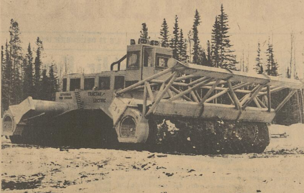
En quelques minutes, cette puissante machine peut se tracer un chemin dans la forêt la plus dense. Cette machine d'une pesanture de 200 tonnes a été transportée de Dorval en Colombie canadienne, en vue d'être utilisée au nettoyage des terrains qui seront inondés à la suite de la construction centrale de Rivière à la Paix. Chacun des rouleaux a une longueur de 40 pieds et pèse 48 tonnes. A une vitesse de quatre milles à l'heure, la machine peut abattre n'importe quel arbre et franchir n'importe quel obstacle sur son chemin.
