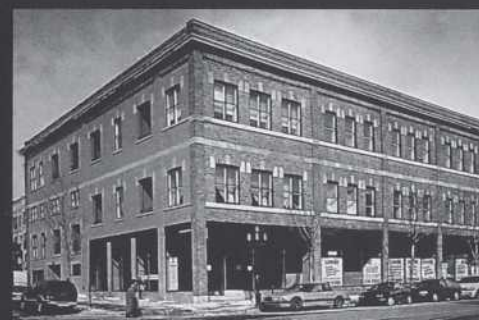
235, rue Laurier Ouest
