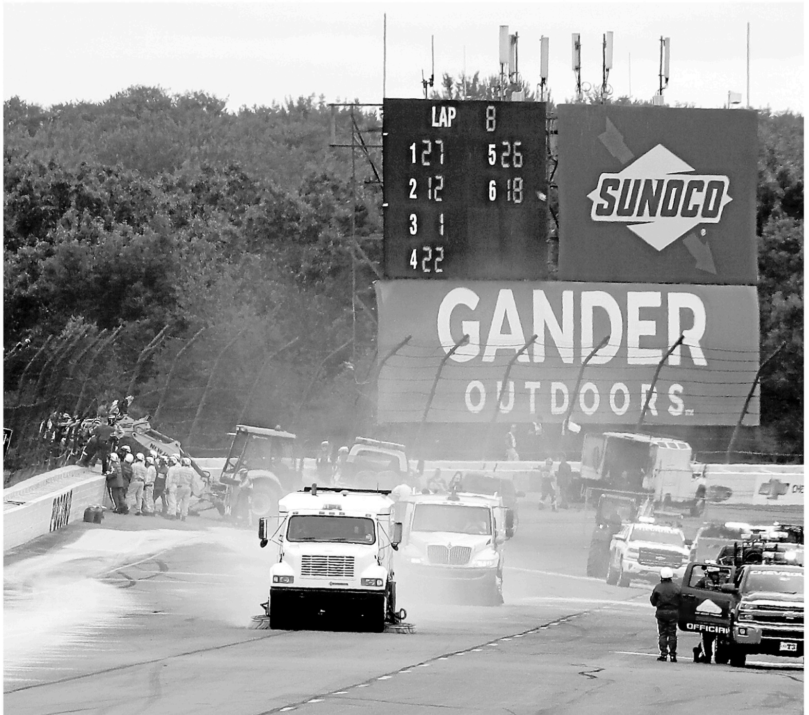
L'épreuve a été interrompue pendant environ deux heures pour permettre au personnel d'entretien de réparer les dommages. — MATT SLOCUM, ASSOCIATED PRESS
