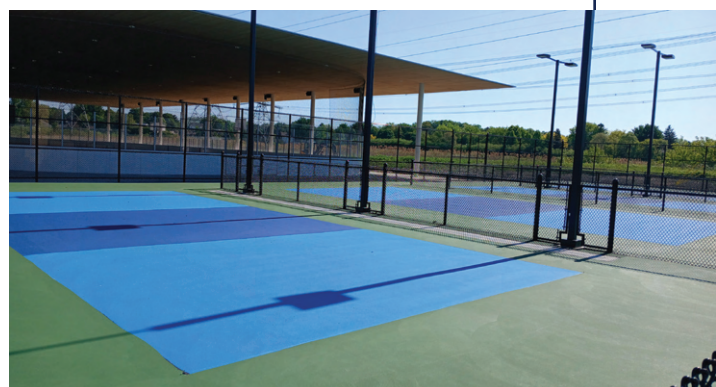
Construction du nouveau polydôme (15 M$)
