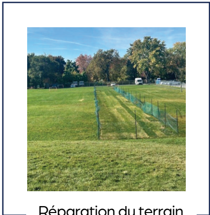
Réparation du terrain de soccer au parc de la Coulée
