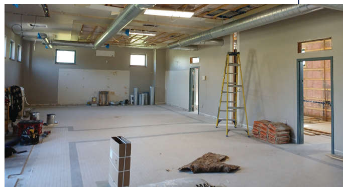
Réfection du chalet de la piscine Roberval (1,7 M$)
