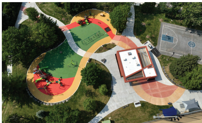
Réaménagement complet du parc Jolliet (5,5 M$)
