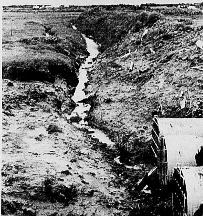
Aboiteau vu du côté des terres: on remarque le canal intérieur, longeant la digue, et les conduits d'évacuation des eaux.
