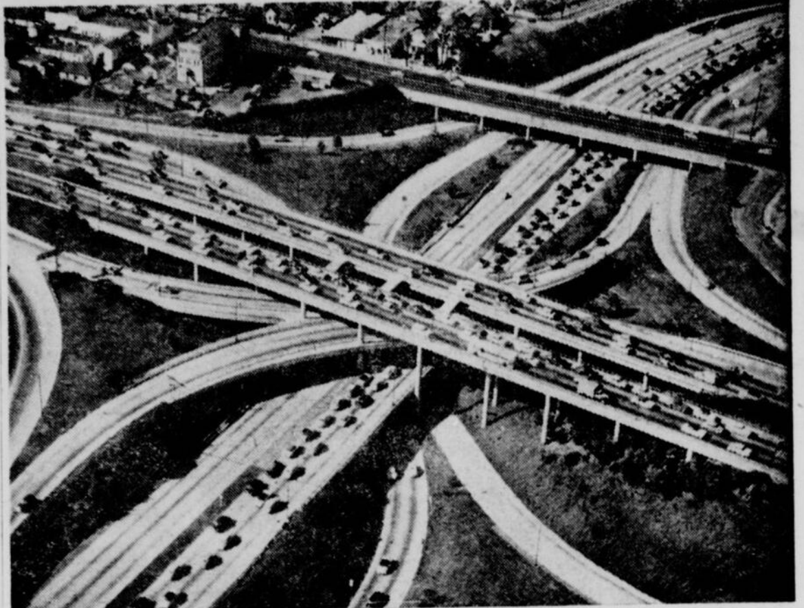
A Los Angeles, on a réussi à résoudre le grave problème de la circulation en construisant des autostrades. Ce croisement d'autostrades, à quatre voies superposées, est situé en plein coeur de Los Angeles. Même aux heures d'affluence, on peut rouler à une grande vitesse.
