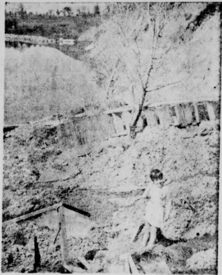
Une vraie bouillie! Les escaliers brisés... les arbres entraînés dans l'effondrement... et l'éboulement menace de se répéter!
