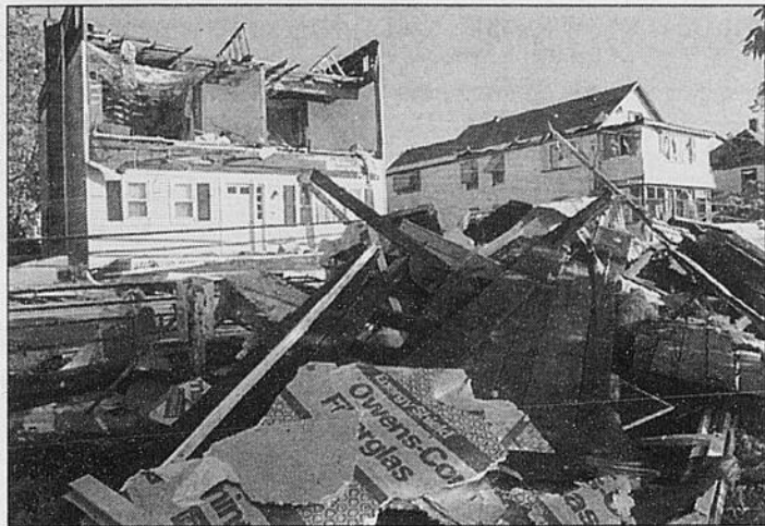
DETRUIT - Cette maison a été complètement éventrée par la force des vents dans l'Etat de New York. Un homme de 32 ans a été tué dans cet édifice.
