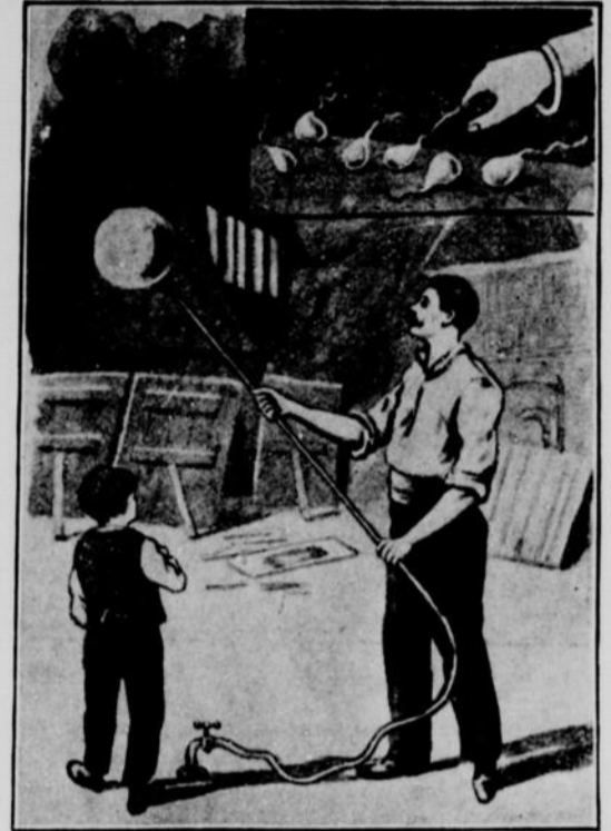
1. Soufflage du verre à l'air comprimé.—2. Les larmes bataviques.
