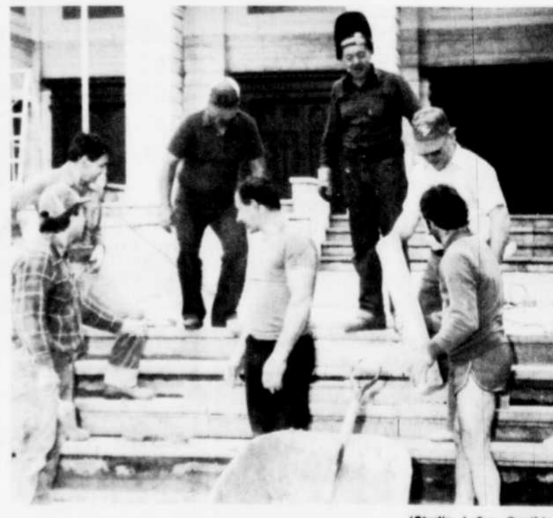
Les Chevaliers de Colomb de Saint-Grégoire ont pris en charge la réfection du perron de l'église. Nous apercevons ci-dessus les ouvriers au travail. Grâce à ce bénévolat, ces travaux ont coûté à la fabrique que les matériaux de rechange.
