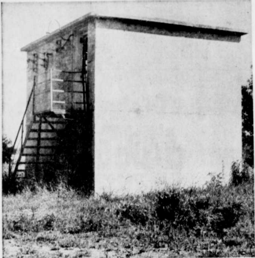
Puits artésien. — La principale source d'approvisionnement d'eau, du service municipal de Coaticook réside en son puits artésien, érigé sur le terrain municipal, non loin du terrain de jeu de l'OTJ, sur la rue Cutting. Cette photo nous montre la bâtisse dont l'apparence ne révèle rien de spécial renferme toutefois les installations du puits artésien dont la capacité est de 675 gallons à la minute.
