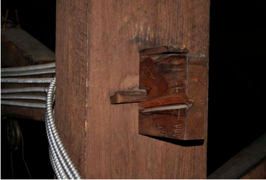
150. Montréal. Église Sainte-Brigide Assemblage a tenons et mortaise (photo Luc Noppen)
