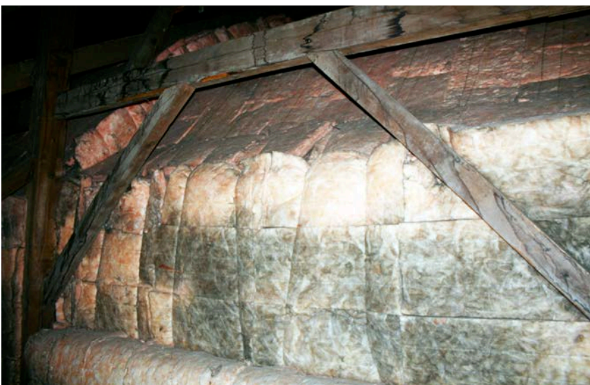
152. Montréal. Église Sainte-Brigide Contreventement longitudinal des piliers de la nef (photo Luc Noppen)
