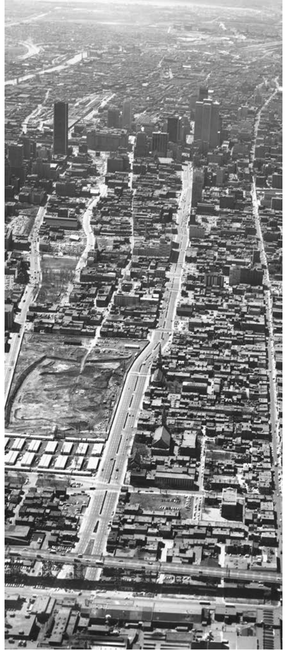
249-250. Montréal, La percée du boulevard Dorchester (aujourd'hui René-Lévesque), dans les années 1950, la construction ultérieure de Radio-Canada et, enfin, la percée de la l'autoroute Ville-Marie, au début des années 1970, ont sérieusement compromis l'avenir de la paroisse (BAnQ, Fonds Armour-Landry, P97,52,15612 et P97,S1,D8183
