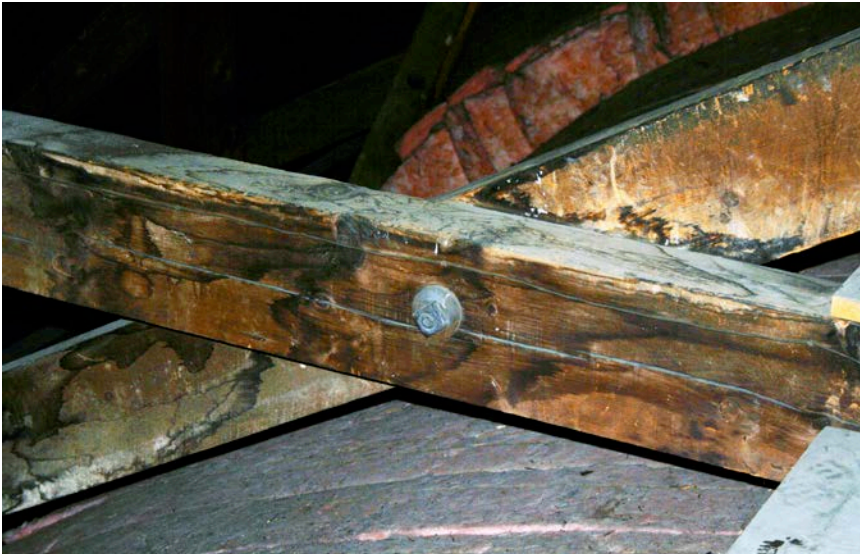
151. Montréal. Église Sainte-Brigide Assemblage boulonné (photo Luc Noppen)
