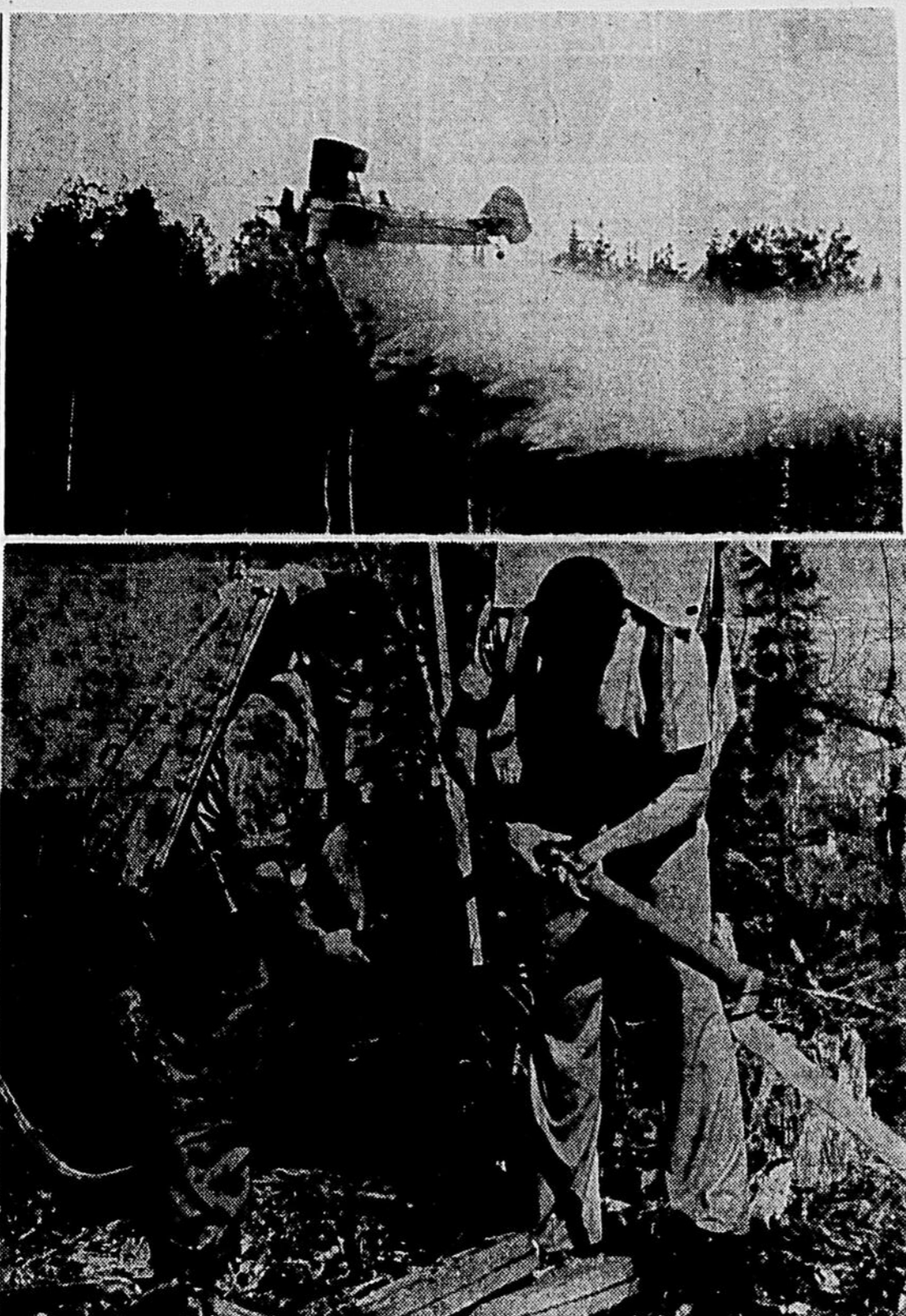
Pour la première fois au Canada, on a fait l'essai, au moyen d'avions "Stearman", d'une solution chimique pour maîtriser les incendies de forêts. Il s'agit du bombardement des arbres à l'aide de borate de calcium sodique qui empêche les flammes de se propager, en attendant l'arrivée de l'équipe de terre qui poursuivra la lutte contre le feu au moyen d'équipement ordinaire: pompes, boyaux, etc.
