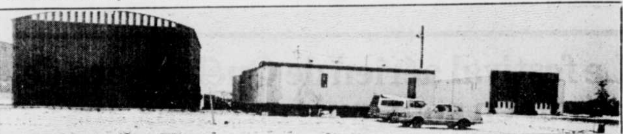
À gauche de la photo, on aperçoit le bâtiment qui abritera le centre de transfert d'Enviro-Mobile, tandis qu'à l'extrême droite, on voit le centre de transfert de Safety Clean.
