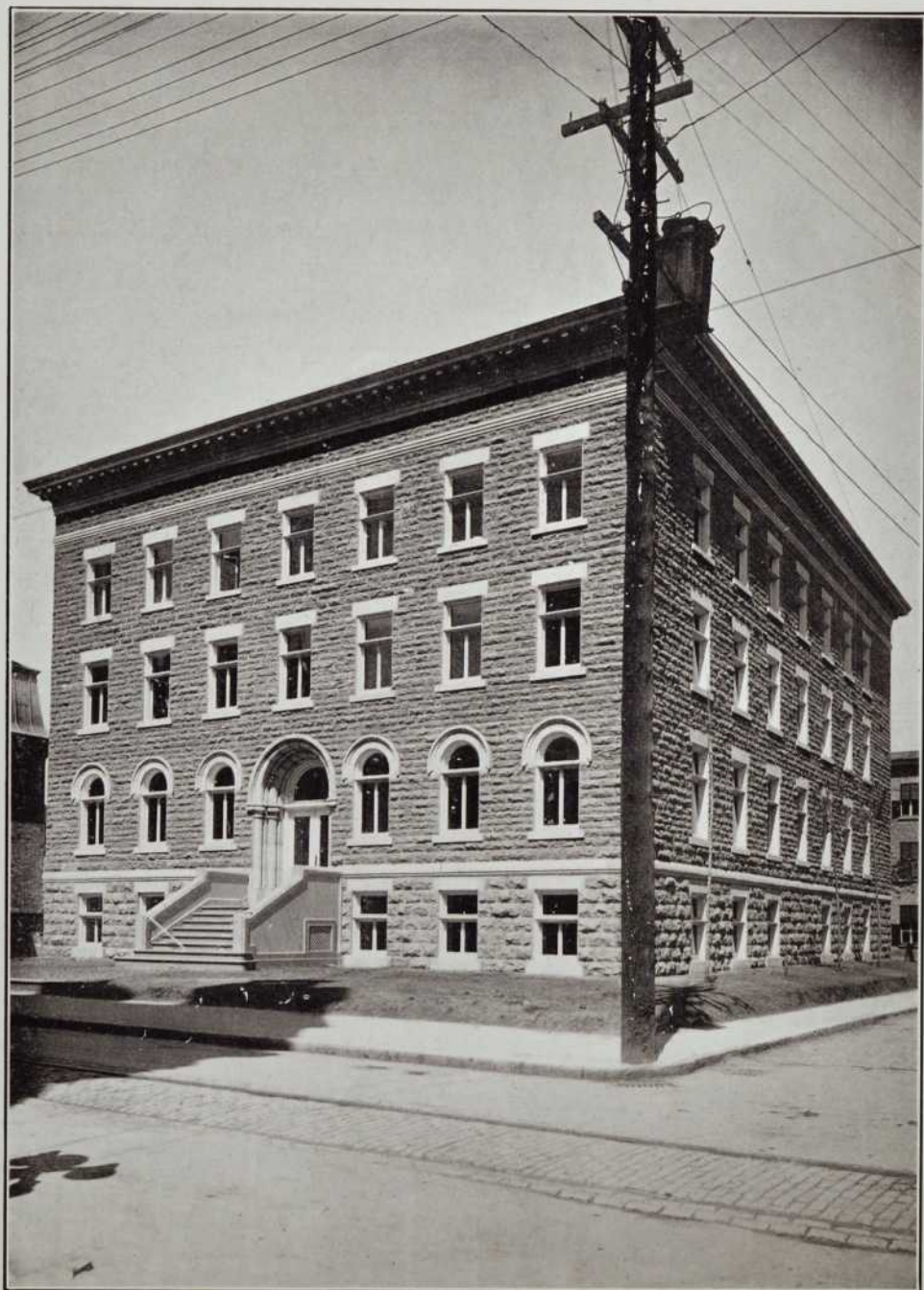
Le nouveau presbytère de Saint-Roch
