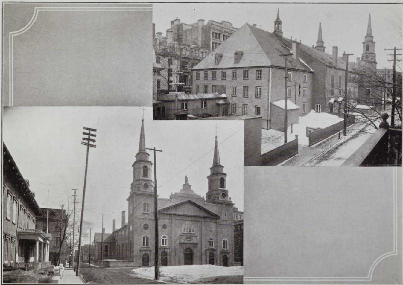
Extérieur de l'ancienne église de Saint-Roch de Québec (1845-1917)
