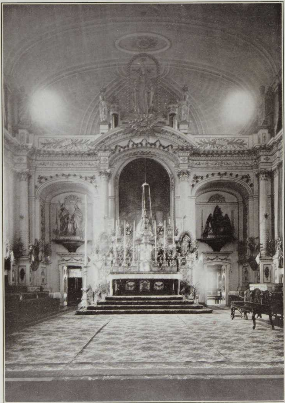
Choeur (Démoli en Mai 1915)
