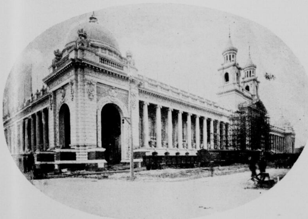
Édifice des industries variées en construction
