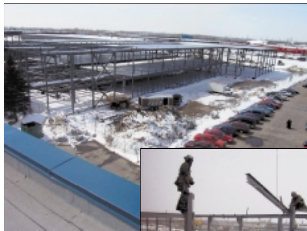
Construction de la structure d'acier.
