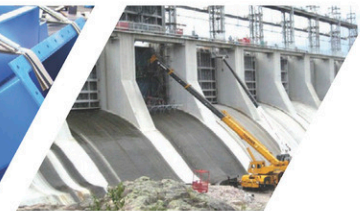
Réparation de vannes (hydro-électricité)
