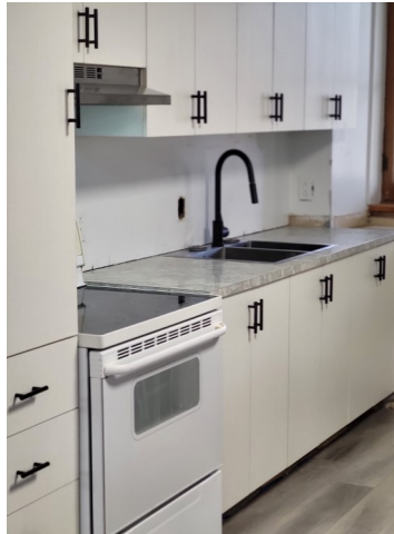
Rénovation au sous-sol du presbytère de Saint-Cuthbert
