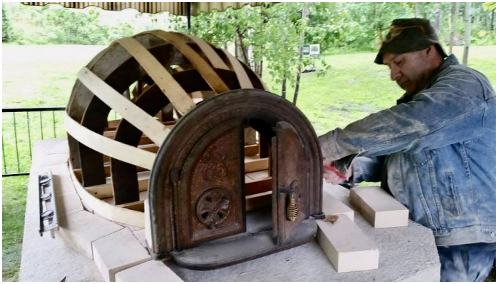
Construction d'un four à pain
