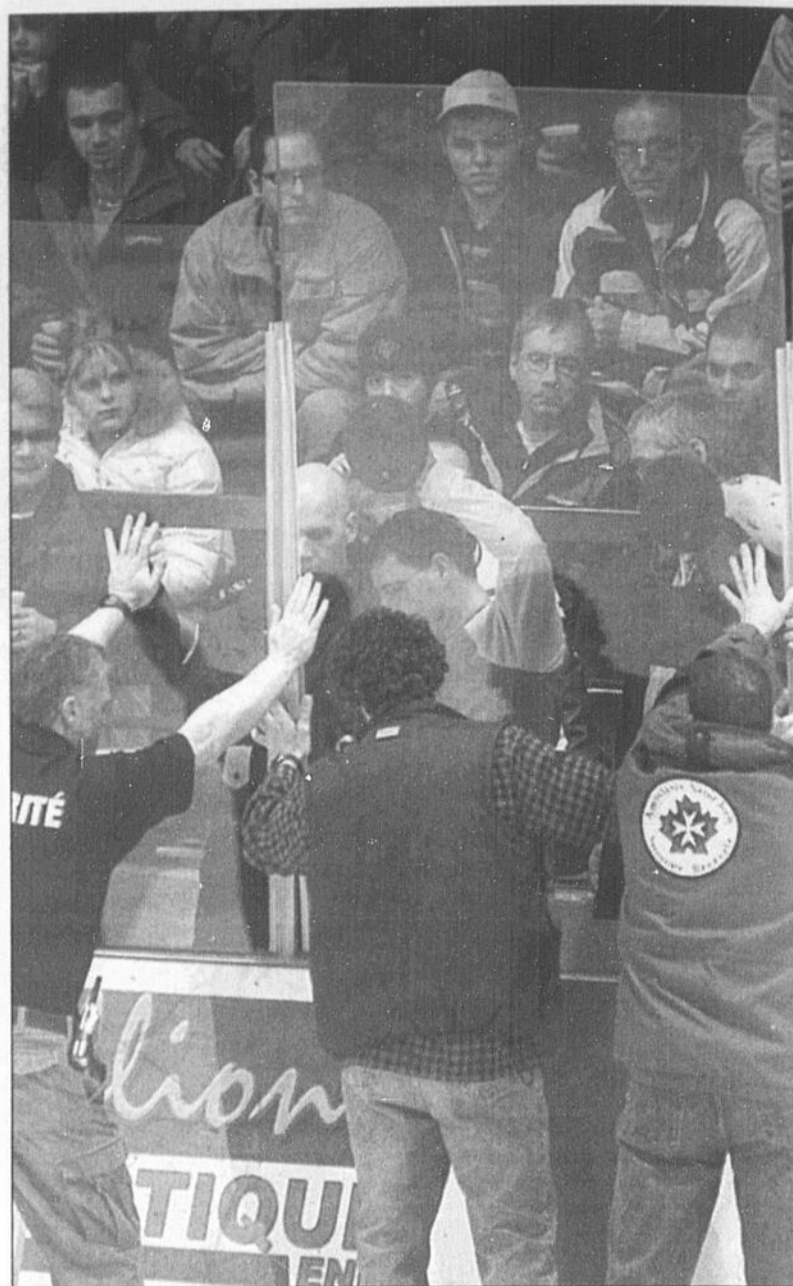
LONG - Les préposés du Palais des sports ont pris pas moins de 45 minutes pour remplacer cette baie vitrée.
