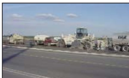
Le recyclage de type 2 avec stabilisation au bitume moussé
