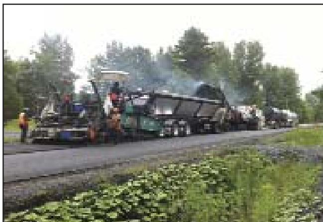
Le recyclage de type 1 avec le train de recyclage à froid
