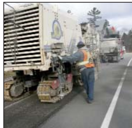
L'exécution du planage fin
