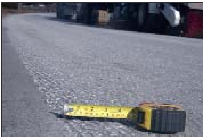
Un exemple du résultat du planage fin
