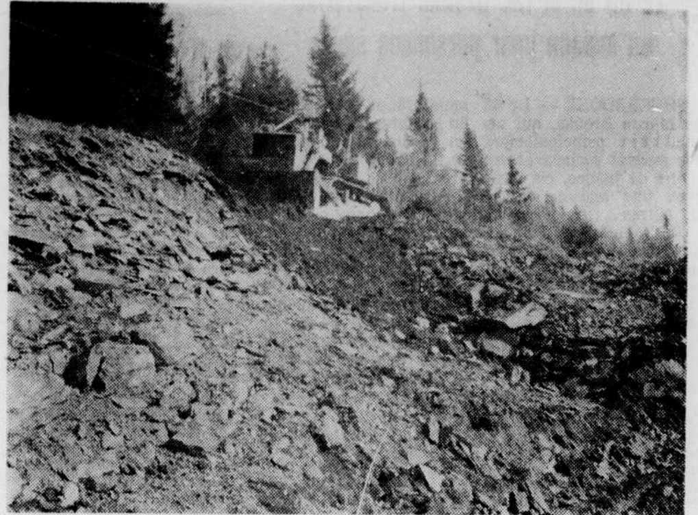
Pour un montant de $99,000, des travaux s'effectuent présentement entre St-Malo et Paquetville. Il s'agit de travaux qui consistent au redressement de la route sur une distance d'un demi mille.
