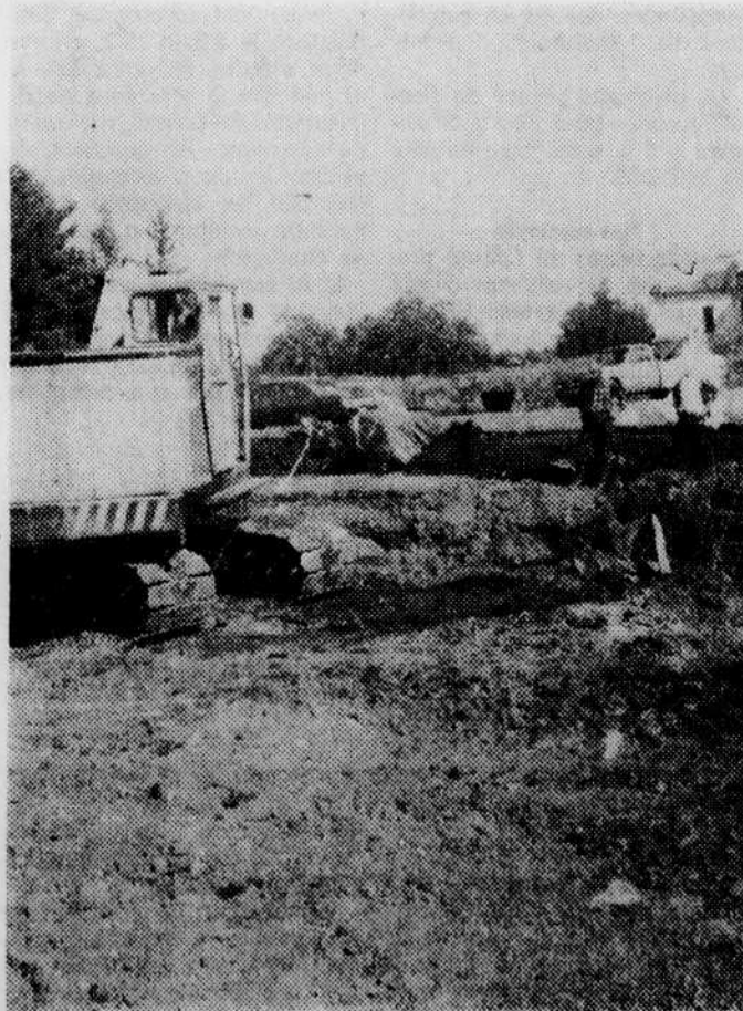
DES TRAVAUX pour un montant global de $134,000 s'effectuent présentement à Birchton. Il s'agit de la reconstruction de chemin en vue d'éviter des courbes prononcées et d'élargir ce même chemin sur une longueur de un mille et plus. Les travaux sont confiés à Arthur Boisvert, construction. (Photo La Tribune, par Mme G. Pomerleau)
