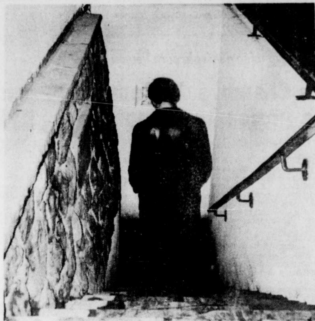
QU'ARRIVERAIT-IL AUX JEUNES qui doivent emprunter cet escalier pour s'enfuir dans le p'tit café de la rue Notre-Dame si un incendie se déclarait près de la porte de sortie. Aucune sortie de secours n'est prévue. Le conseil municipal a l'intention d'y voir.
