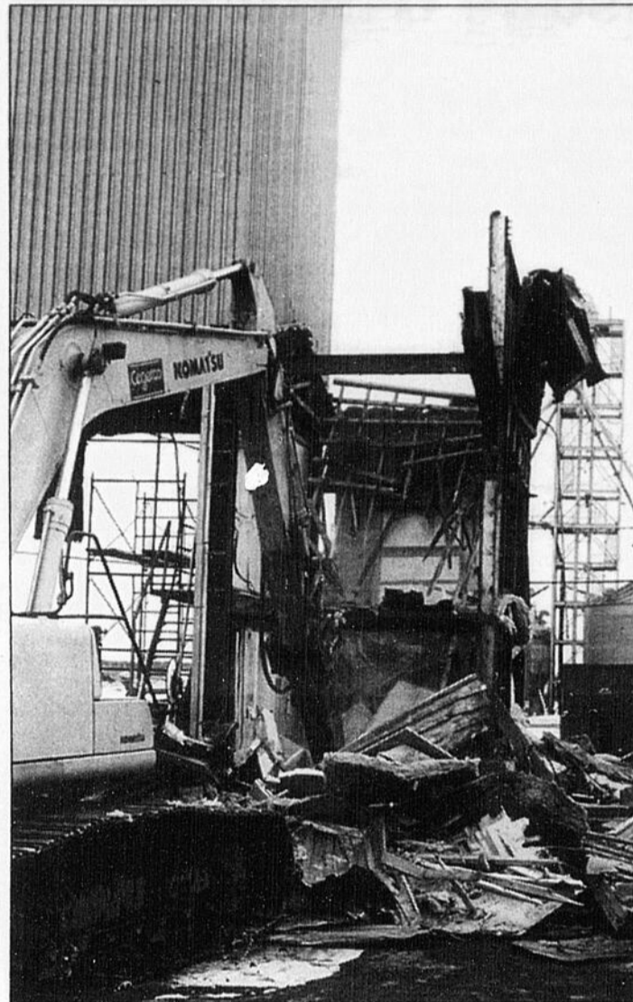
PROJET - Nutrinor a amorcé en début de semaine, dans le rang Six Sud de Saint-Bruno, la démolition de ce qui restait de sa meunerie frappée par un incendie et il lui en coûtera autour de 6,5 millions $ pour reconstruire en plus moderne et mieux informatisé.
