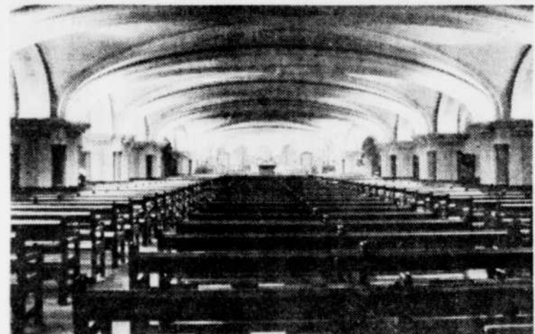
La basilique de Sainte-Anne-de-Beaupré dispose maintenant de lieux de culte agrandis, avec le parachèvement de la crypte souterraine qui permet d'accueillir plus de 800 fidèles. Gérard Ouellet en a fait la visite et raconte.
