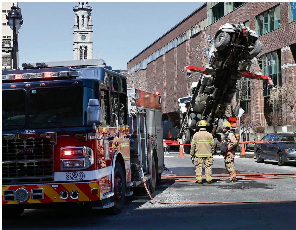
MONTRÉAL – Un travailleur a perdu la vie et un autre a été blessé gravement lorsqu'une grue s'est renversée au centre-ville de Montréal, dimanche matin. Le drame est survenu vers 10 h près du pavillon Marie-Gérin-Lajoie de l'UQAM, à l'intersection du boulevard René-Lévesque et de la rue Saint-Denis. Pour une raison inconnue, la grue installée sur une plate-forme d'un camion a basculé sur le trottoir. Une des victimes aurait fait une chute d'une vingtaine de mètres pour rester coincée sous la grue. — ROBERT SKINNER, LA PRESSE
