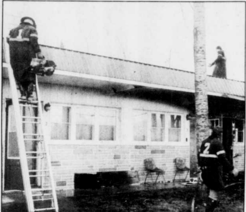
Les chambres nos 4 et 5 du motel Le Normand ont été entièrement détruites par un incendie dans la nuit de lundi à mardi.
