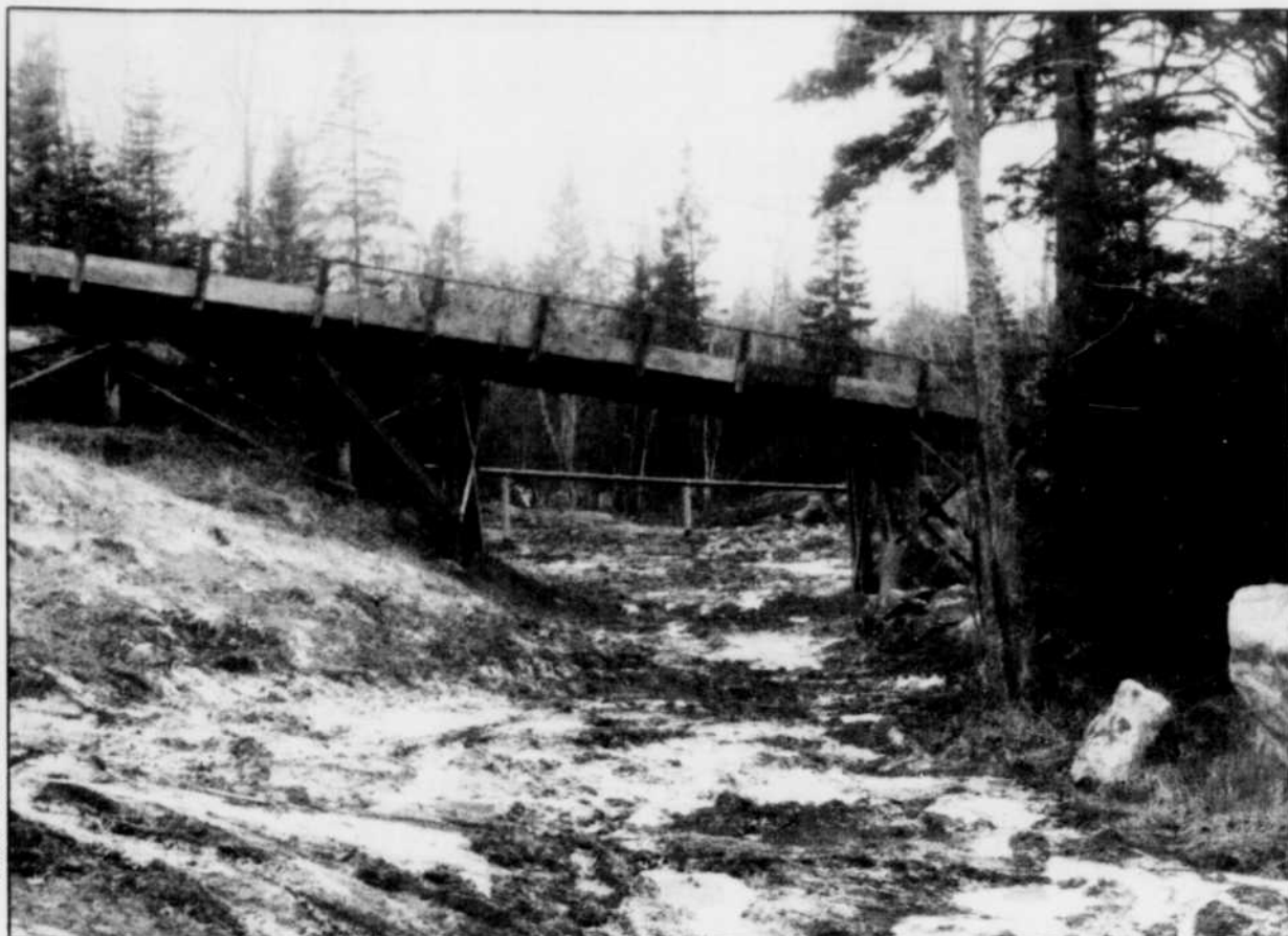
Certains imbroglis techniques ont eu pour effet de faire apparaître des conduites à des endroits peu appropriés.
