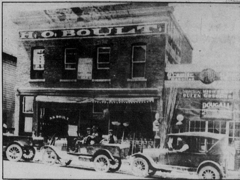
Cette photo, prise en 1923, montre le poste d'essence où les Hullois s'arrêtaient, avant d'aller à la messe, ainsi que la quincaillerie du père de M. Robert Boul.
