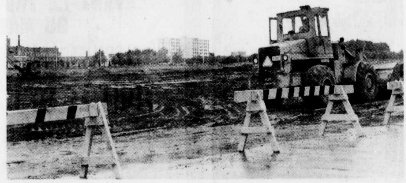
C'est parti Immédiatement après la levée symbolique de la première pelletée de terre lundi dernier, les travaux ont débuté pour la construction du futur centre commercial "Le Carré four des Bois-Francis" et comme on peut le constater, l'excavation va déjà bon train. (Photo La Tribune, Victoriaville, Serge Beaucher)
