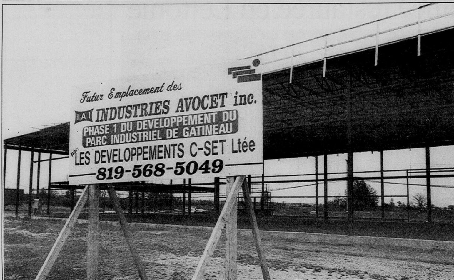
Le chantier de construction de l'usine de condoms de Gatineau a été paralysé à cause d'un différend entre l'entrepreneur général et les propriétaires.
