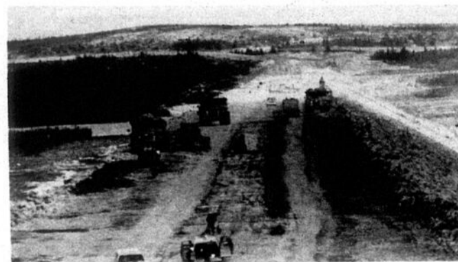
On remarque un des barrages en construction. La base de ce barrage est de 600 mètres de large et lorsqu'il sera terminé, il n'aura plus que 30 mètres de large. (Photo PM)
