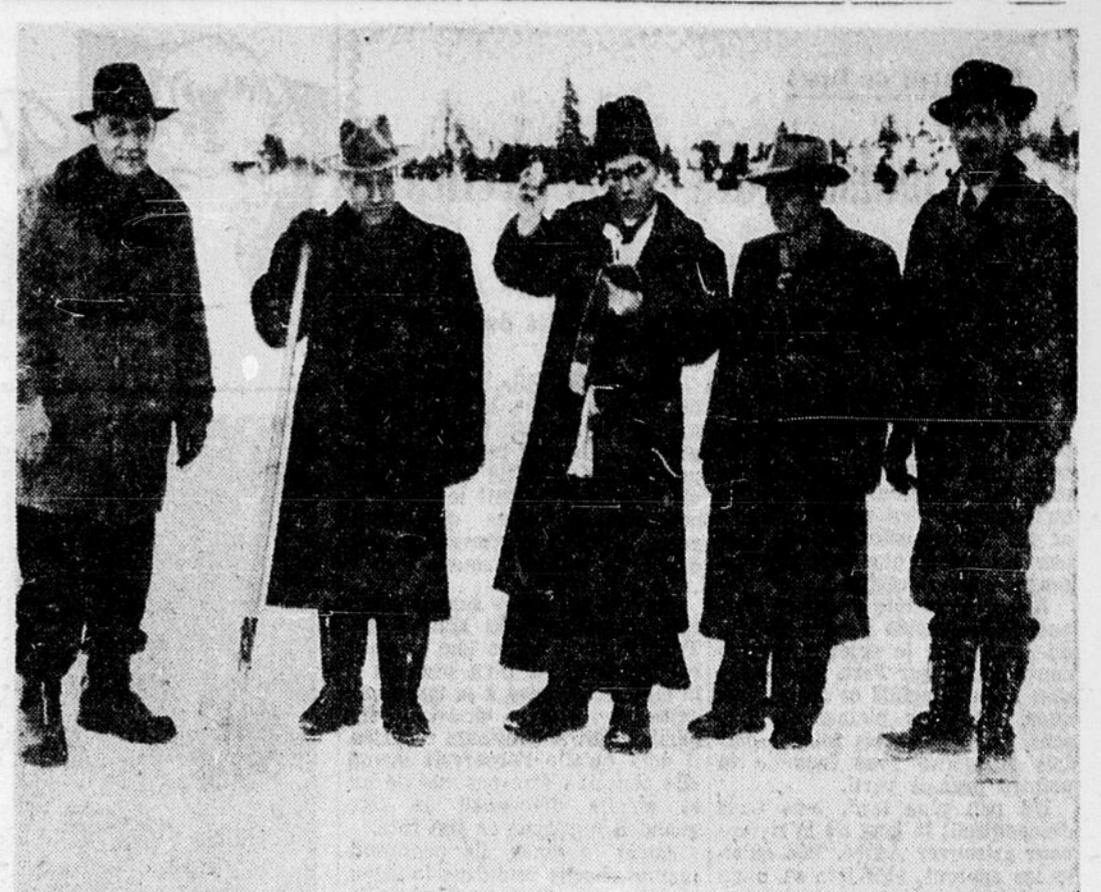
LES "HABITATIONS EMMANUEL" DE MANIWAKE — Inauguration et bénédiction des travaux de construction domiciliaire en autre transaction commerciale. Le t. h. James J. Gardiner, ministre de l'Agriculture, a tenu à préciser qu'il "est complètement d'accord" avec son collègue. (La rumeur veut que 2,250,000 livres de fromage néo-zélandais soient en route vers le Canada. Cette rumeur a soulevé de vives protestations de la part des producteurs de fromage canadiens.)
