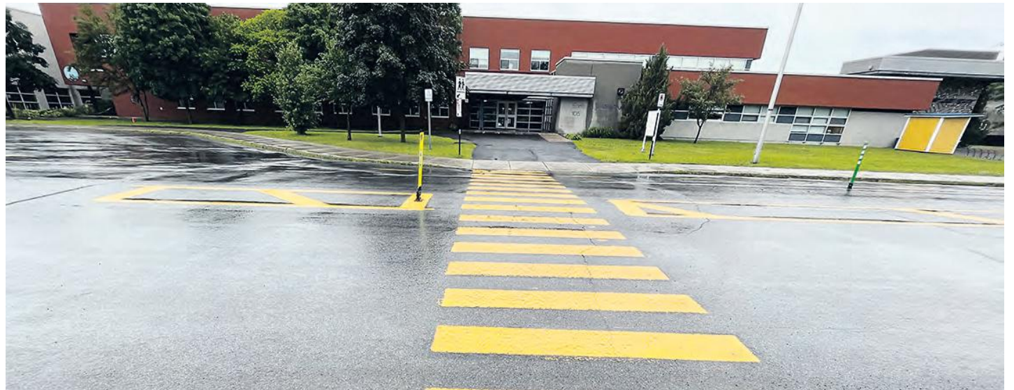
Des travaux pour l'ajout d'un trottoir et d'une avancée de trottoir devant l'école de la Mosaïque. (Photo : Frank Jr Rodi)
