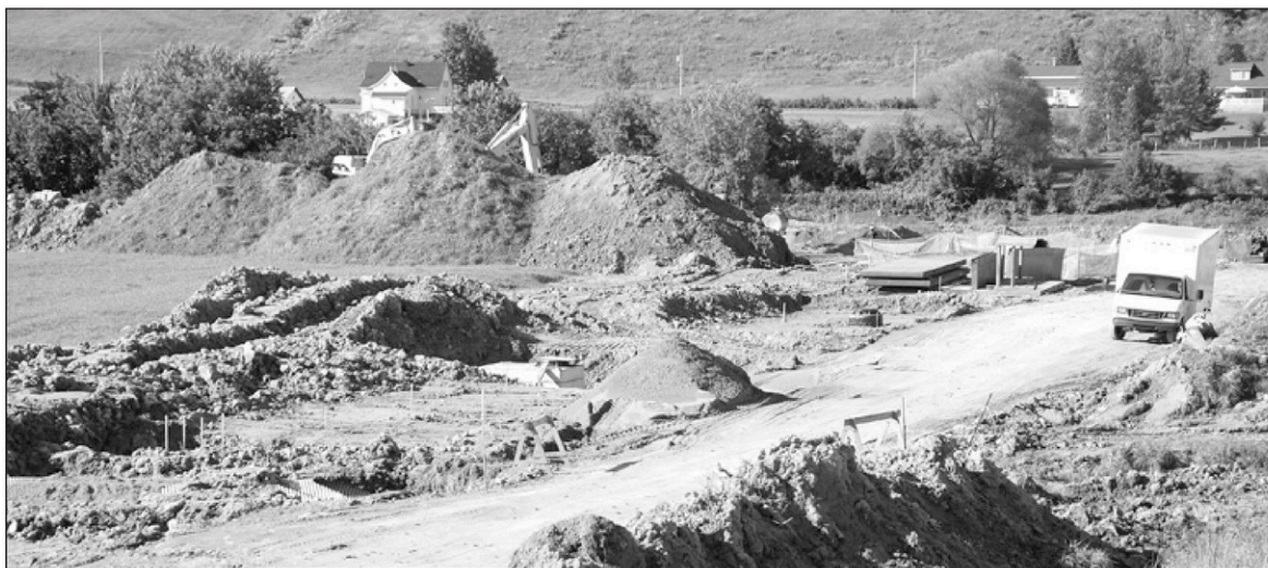
Les travaux de la prise d'eau et de la conduite d'amenée sont déjà amorcés.
