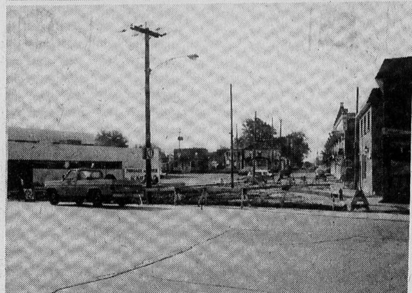
La ville de Valleyfield a débuté les travaux à l'angle des rues Académie et Victoria. Les feux de circulation devraient être installés prochainement. La circulation dans le centre-ville sera grandement améliorée grâce à ces modifications. (Photos Le Soleil - Jacques Smith)
