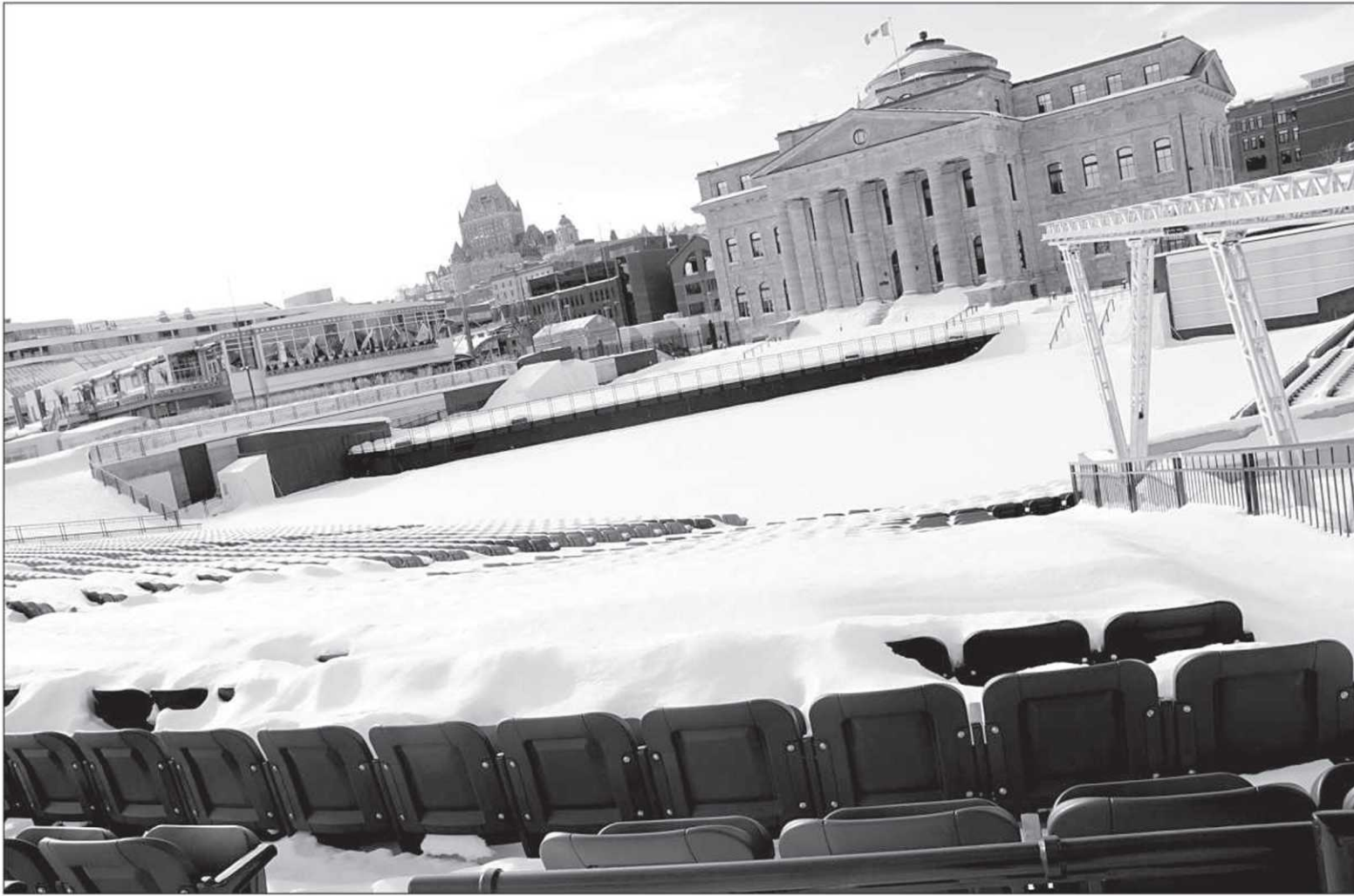
L'Agora du Vieux-Port, cette salle de spectacles en plein air héritée de Québec 84, est négligée depuis sa coûteuse réfection en 2008. — PHOTOS LE SOLEIL, MARTIN MARTEL
