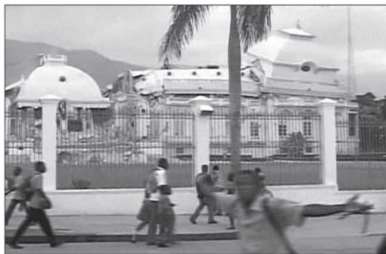
Plusieurs des grands édifices du centre, à commencer par le Palais présidentiel, ne seraient plus que des amas de ruines. — PHOTO REUTERS
