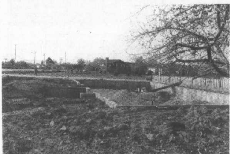
C'est cette construction commencée il y a quelques semaines qui a fait déborder le vase pour quelques résidents des rues Des Bouleaux et Croissant Vanier à Otterburn Park.
