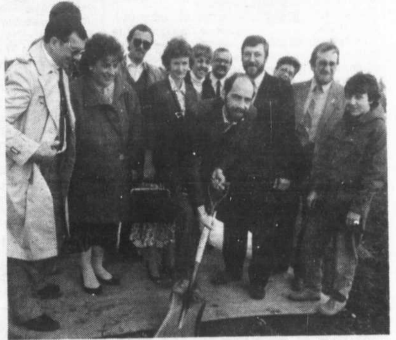
Le conseiller Yves Dussault lève la première pelletée de terre d'un projet de dépanneur mis de l'avant par Jean-Pierre Chabot, ex-directeur général de la ville (debout derrière), à l'intersection Bella Vista, Des Pinsons et Des Alouettes.
