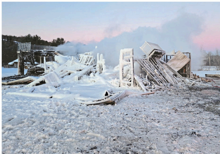
Les ruines de la résidence (Photo SSI de la Régie des Trois Monts)
