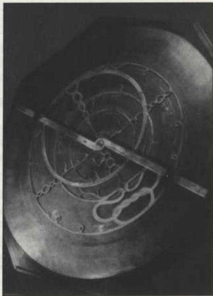
Galilée, inventeur et collectionneur, posséda cet astrolabe datant de 1534 et qui servait à mesurer la hauteur d'un astre au-dessus de l'horizon.
