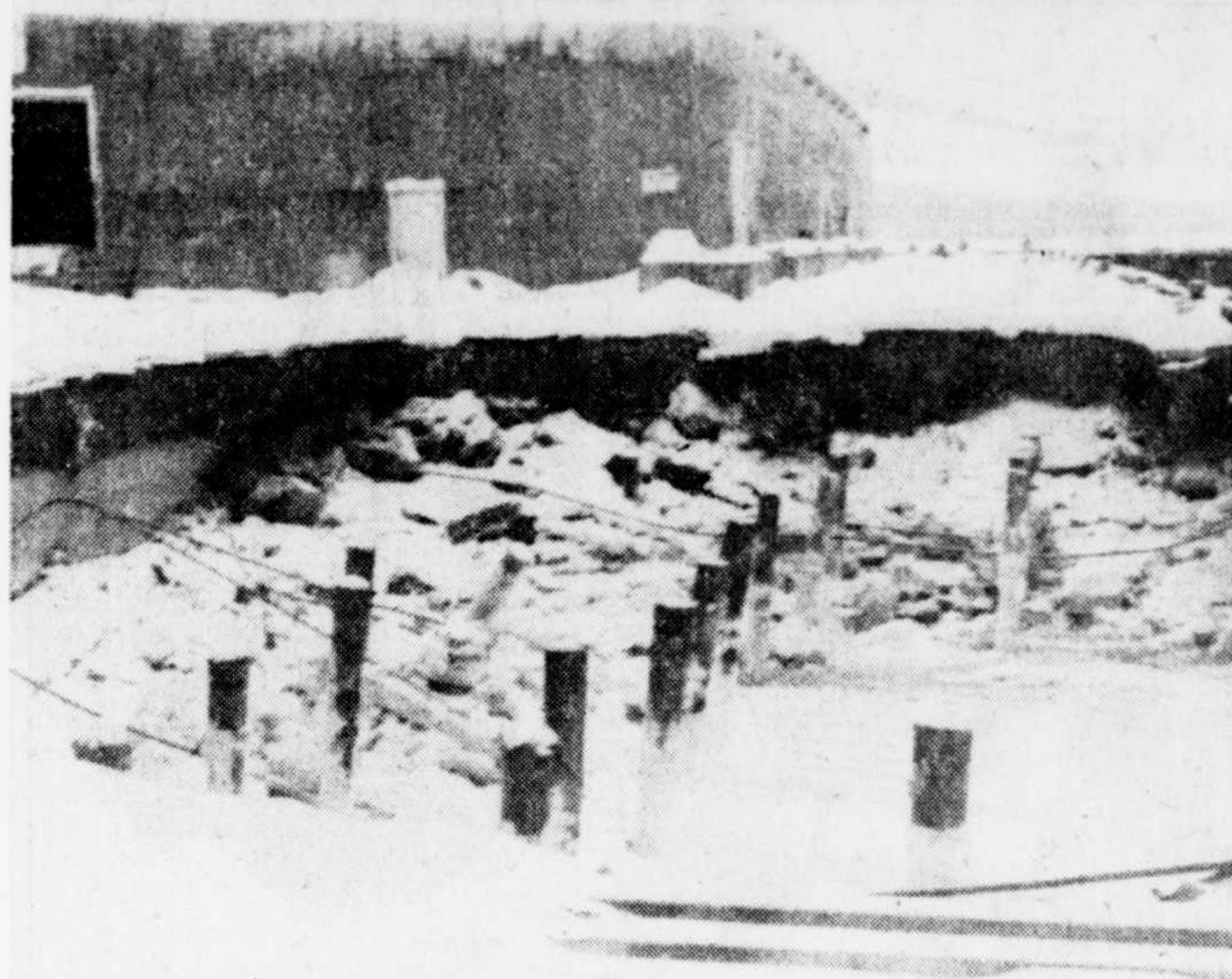
En attendant la réparation ou l'agrandissement, le quai a été protégé temporairement par l'enrochement
