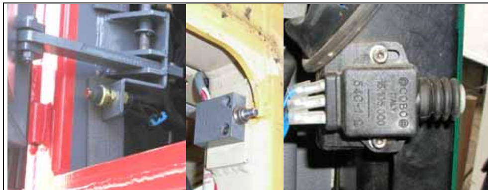
Figure 9 : Interrupteurs électromécaniques de position au niveau des portières
