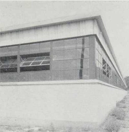
Ci-haut, vue d'angle qui met en évidence la fenestration continue qui ceinture l'usine. A côté, deux coupes de mur, l'une pour la partie usine, l'autre pour la partie bureaux.
