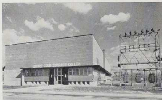
Ci-haut, vue extérieure montrant les transformateurs qui pourront servir en cas d'urgence. En effet, même si l'isolation suffirait à maintenir les températures froides pour un temps appréciable, il faut quand même prévenir les longues pannes d'électricité.
