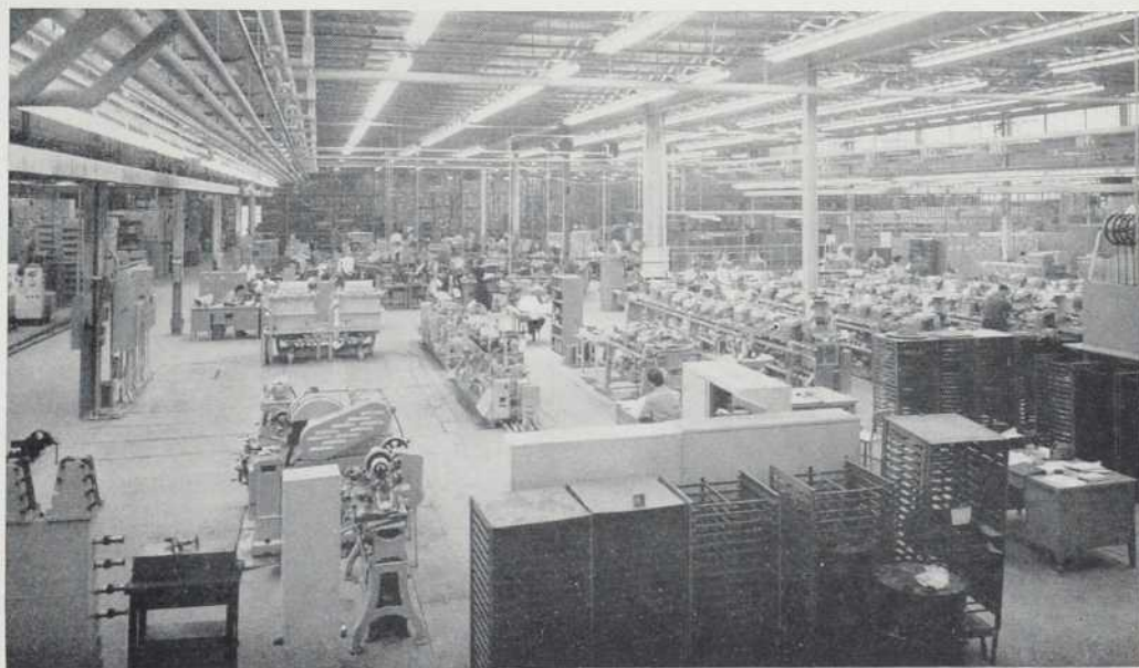
Ci-bas, vue générale de l'usine. L'outillage, très mécanisé, requiert peu de main d'œuvre. Même si l'édifice suffit amplement aux besoins actuels, on a prévu des possibilités d'agrandissement en profondeur pour l'usine et en hauteur pour les bureaux.
