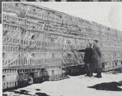
Photo du haut: Utilisé comme fenêtre temporaire, le Polythène protège efficacement contre les intempéries pendant les travaux de construction.
