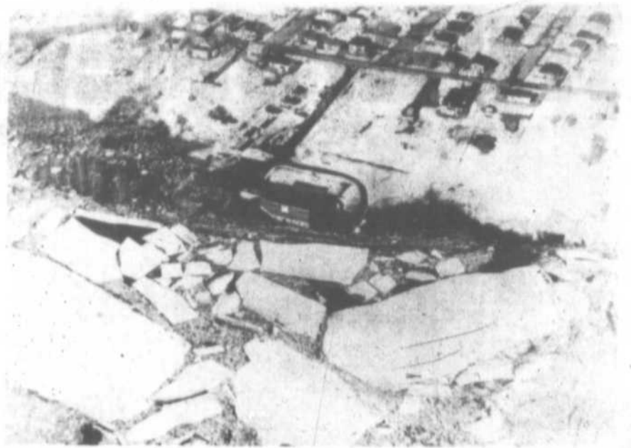
Voici une photo aérienne de l'usine de filtration de Nicolet au lendemain des dommages. Au plus fort de la débâcle, l'eau et la glace avaient envahi complètement le sous-sol.
