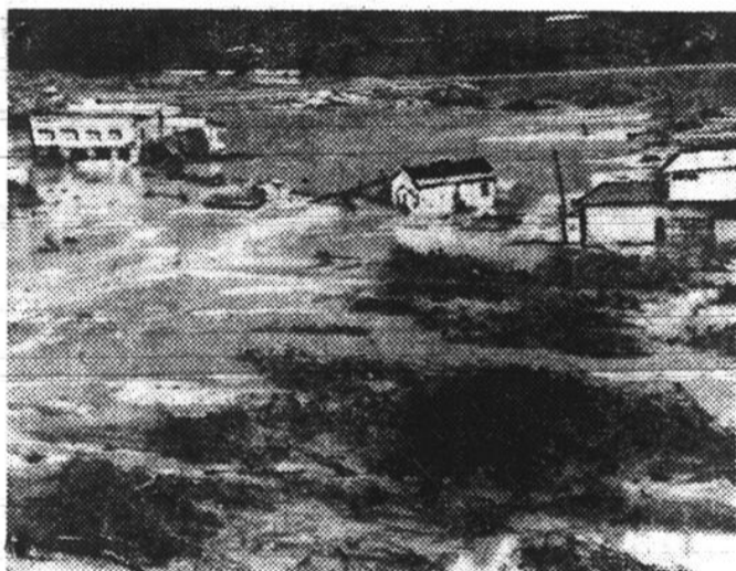
Klamath, Californie — Voici l'aspect que présente aujourd'hui le centre de la ville de Klamath, en Californie. On remarque, à droite, la maison qui est allée s'immobiliser sur la toiture d'une autre résidence.
