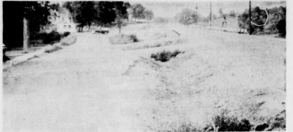
LE PETIT ST-GEORGES — A l'extrémité est de la rue St-Georges, dans le quartier que l'on appelle souvent le "Petit St-Georges", la ville de Windsor s'apprete à entreprendre des travaux. Il s'agira de combler l'excavation laissée ouverte entre l'ancien et le nouveau tracé de la rue St-Georges, et d'aménager les entrées privées. On projette également de terrasser le terrain situé entre les deux tracés.
