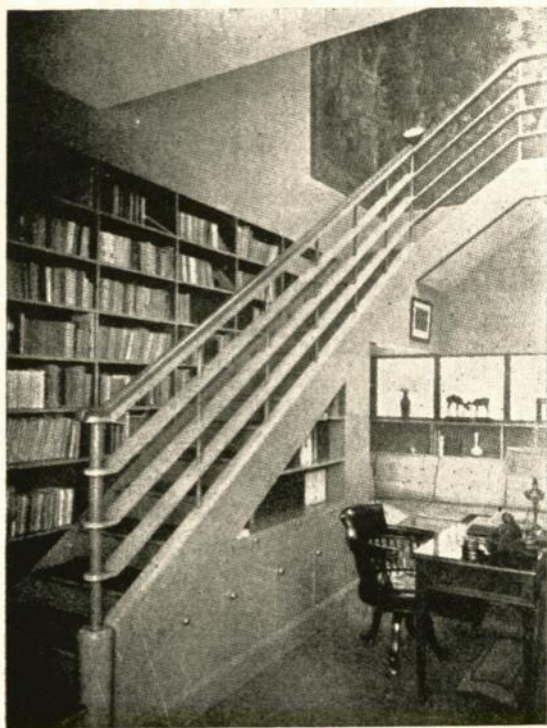
Départ et rampe d'escalier métallique qui sert à la fois d'échelle de bibliothèque.
