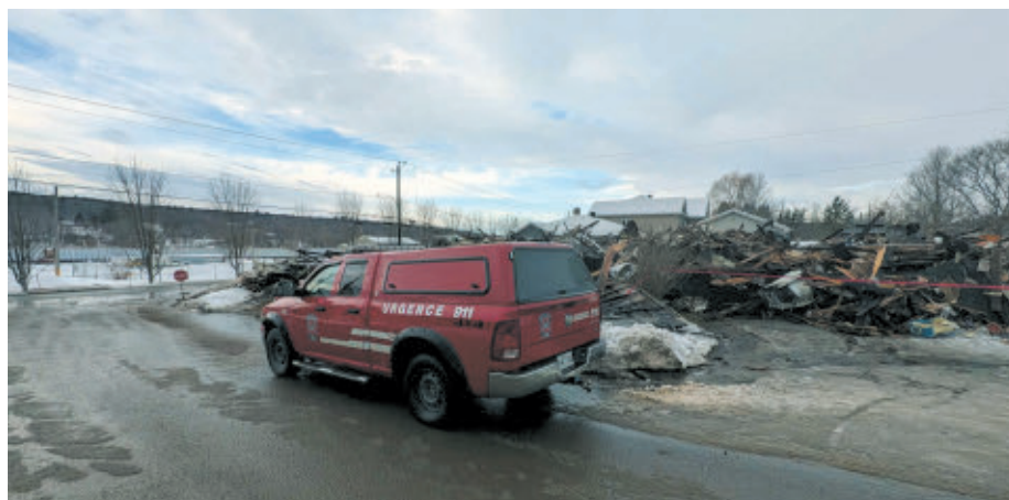
C'est ce qu'il reste de l'immeuble de 11 Logements sur la rue King à Richmond
