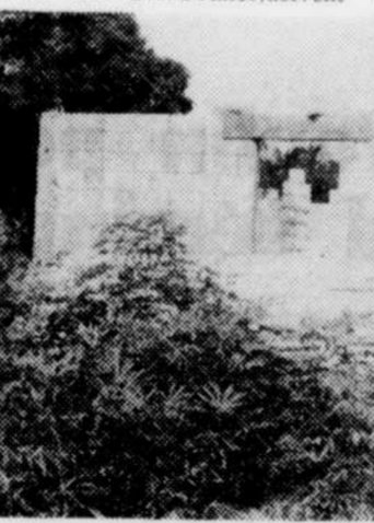
UNE ECOLE A FLON — Grâce aux profits du rallye Tiers-Monde de Victoriaville et au travail des stagiaires des Bois-Francs en Haïti, on est à réaliser une école primaire à Flon dans ce pays. On voit ici un aperçu des travaux effectués et devant être terminés prochainement. (Photo Roland Gingras, Victoriaville)
