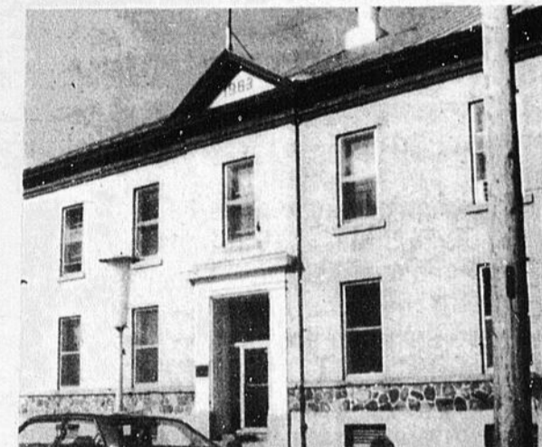
Le bureau d'enregistrement de Berthier ne déménagera semble-t-il pas avant un bon moment.
